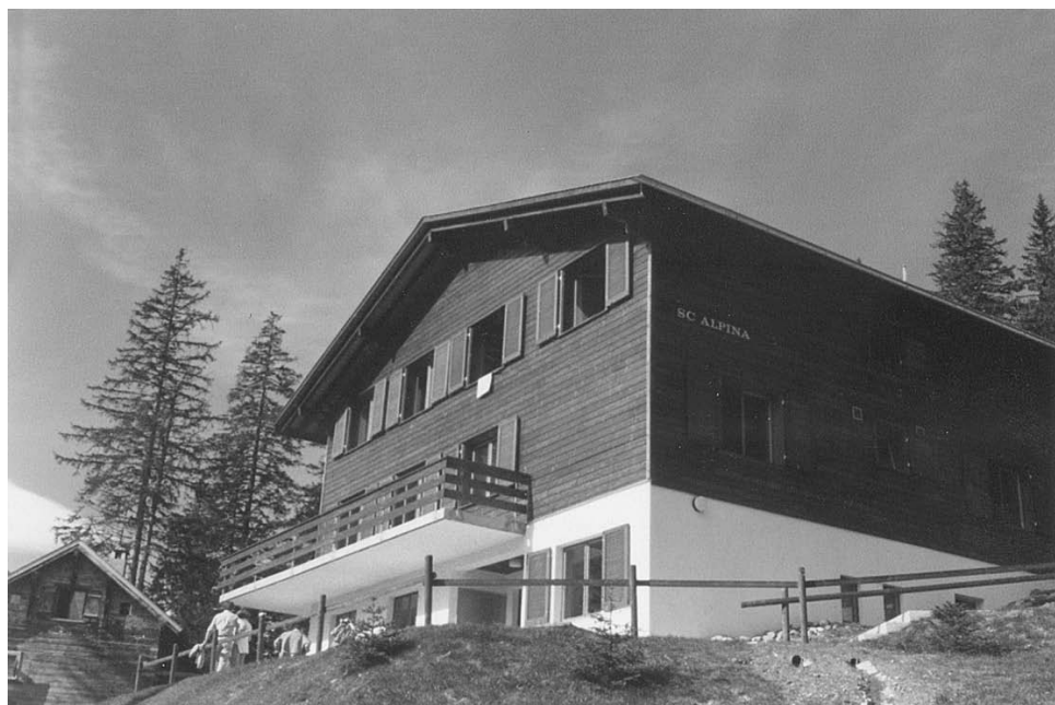
Das Skihaus Alpina nach den Umgebungsarbeiten 1978
