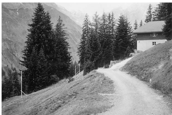
Bauplatz mit Bauprofil
