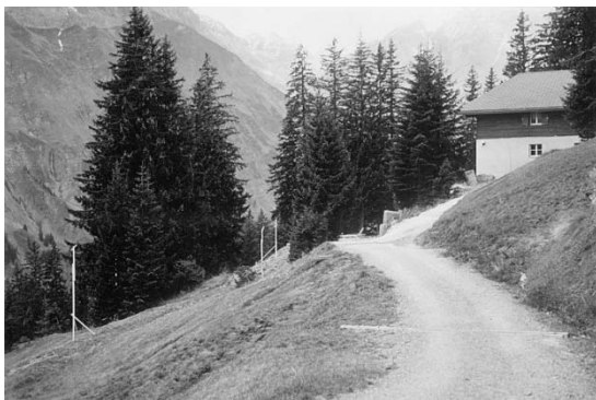
Bauplatz mit Bauprofil
